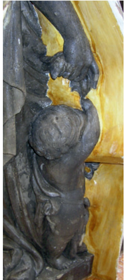
3 Boudin de joint lissé et bouché
